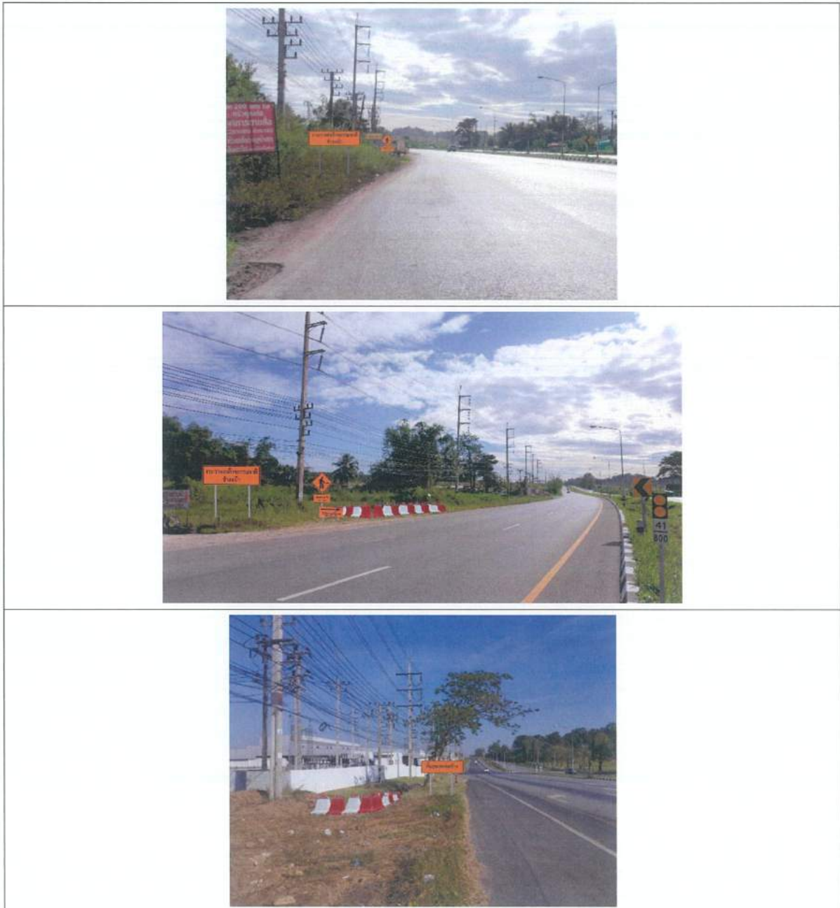
รูปที่ 4.4-1 ตัวอย่างการติดตั้งป้ายเตือนบริเวณบ่อรับ-บ่อส่งของการวางท่อในพื้นที่เขตทางของถนน ทล.344
